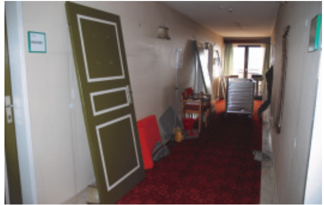
Ausräumen des B- Traktes
