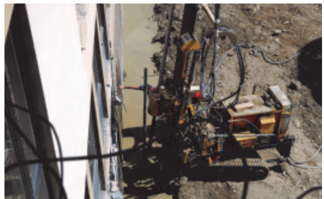
Vorbereiten des Fundaments
