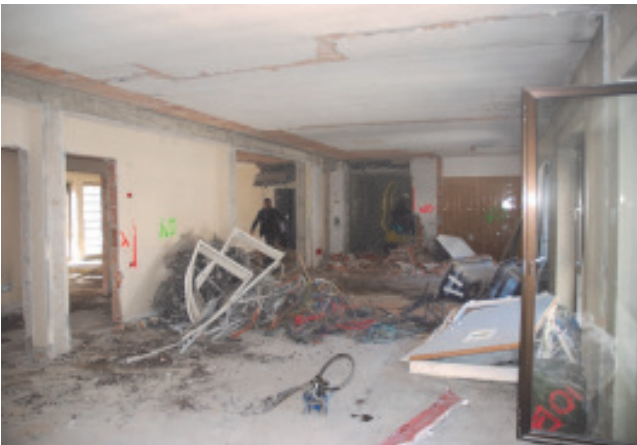
Abbrucharbeiten im B- Trakt
