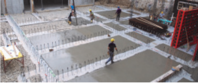
Die Arbeiten schreiten voran
