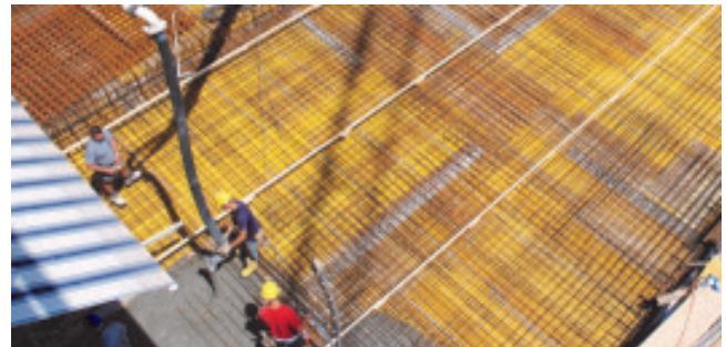
Betonieren der ersten Decke des Zubaus
