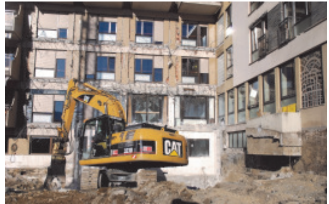
Abbruch- und Aushubarbeiten
