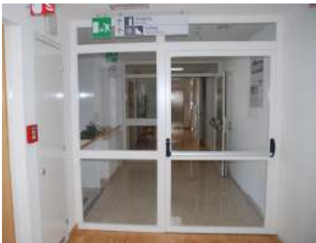
Die neue Brandschutztür im 5. Stock
