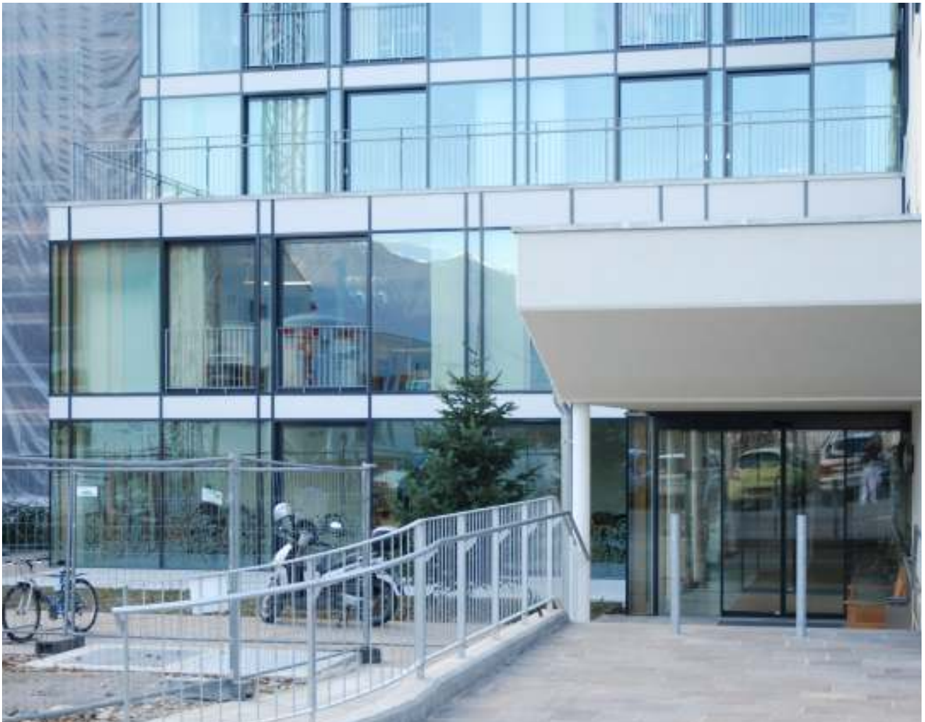
Der neue Eingangsbereich
