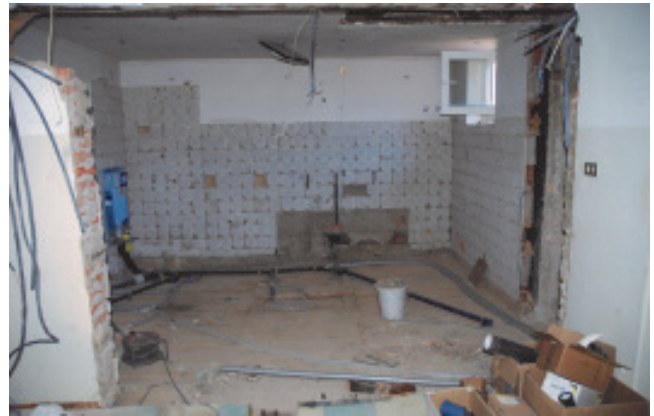
Umbau des Stationsbads
