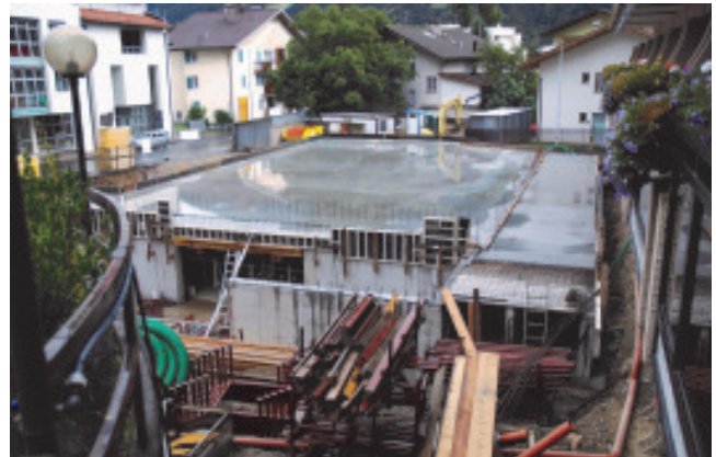
Tiefgarage: Kurz vor Fertigstellung
