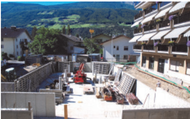
Bau der Tiefgarage
