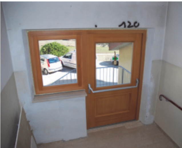
Errichtung des Notausgangs
